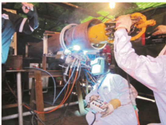
焊接机器人海上焊接试验
