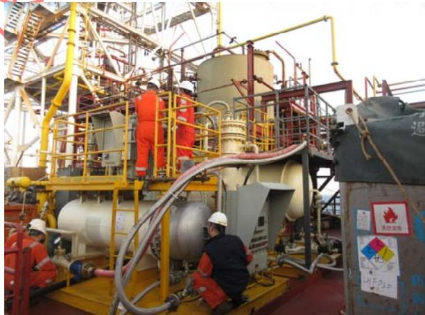
2020年12月26日-2021年1月14日，管式紧凑型电场破乳器工程样机入驻中海油深圳分公司流花(LH)11-1油田作业区“南海胜利号”FPSO，进行了为期19天的老化油处理设备现场实验。流花(LH)11-1油田的油井采出液中携带有大量粒径小的礁灰岩黏土，具有很强的吸油性，老化油主要来源于动态电脱盐器(EDD)中的乳化层和底部油泥、水力旋流器产生的污油等。截止目前，舱底老化油库存量达数万桶，不仅严重侵占了“南海胜利号”FPSO的宝贵舱容，而且造成资源浪费。该老化油具有原油比重较大(20℃时达0.934属重质油)、黏度较大、稳定性较强、杂质含量较高等特点，虽然前期有单位曾尝试过采用“加热升温+化学破乳剂+卧螺沉降离心机+碟式离心机”等工艺流程进行处理，但因运行成本高、维护麻烦等缺点而难以持续进行。
