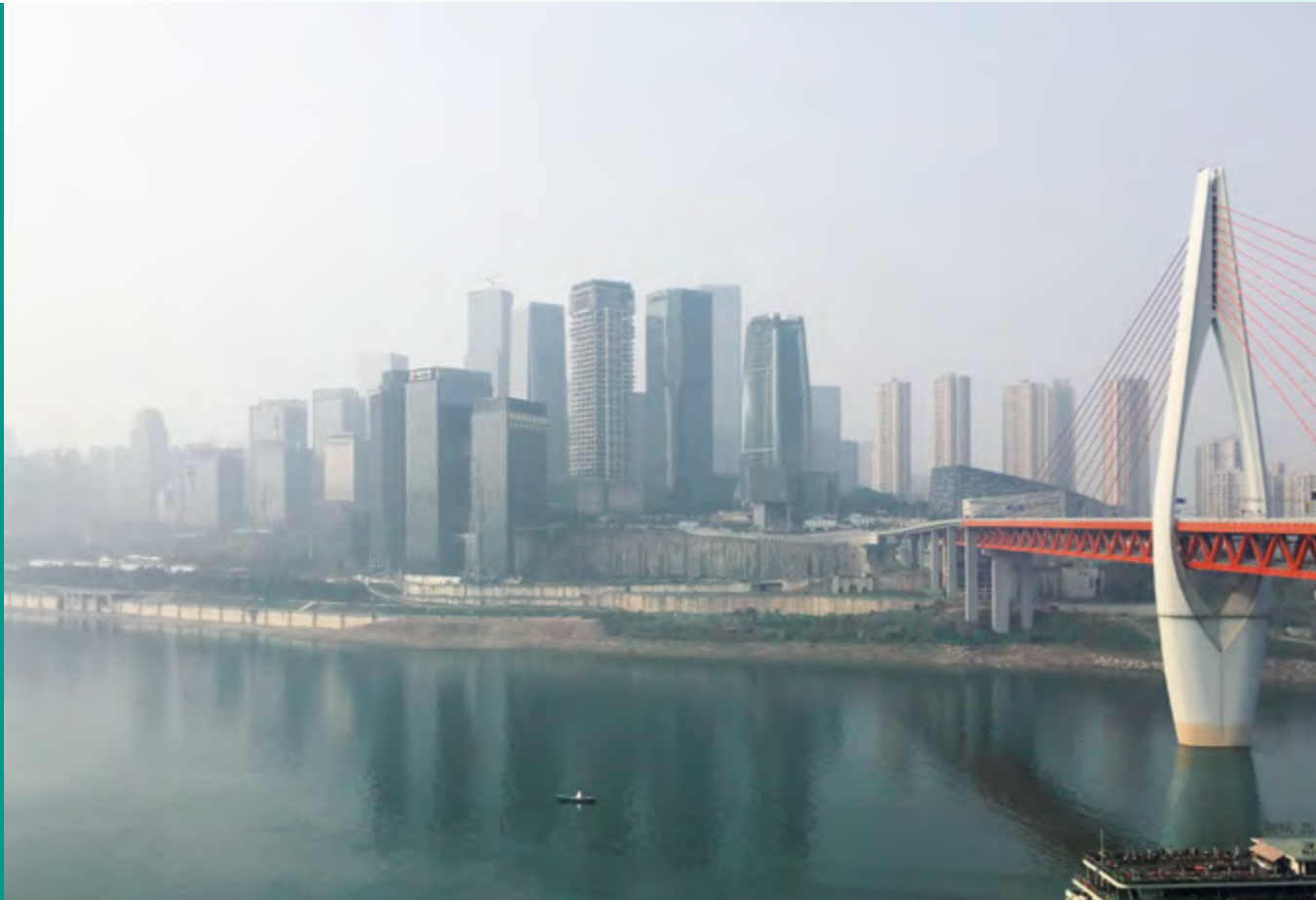
Blick auf Chongqing View of Chongqing 重庆江景
