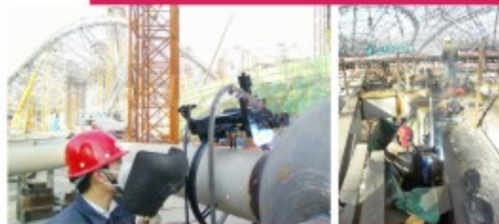
C型柱的焊接
