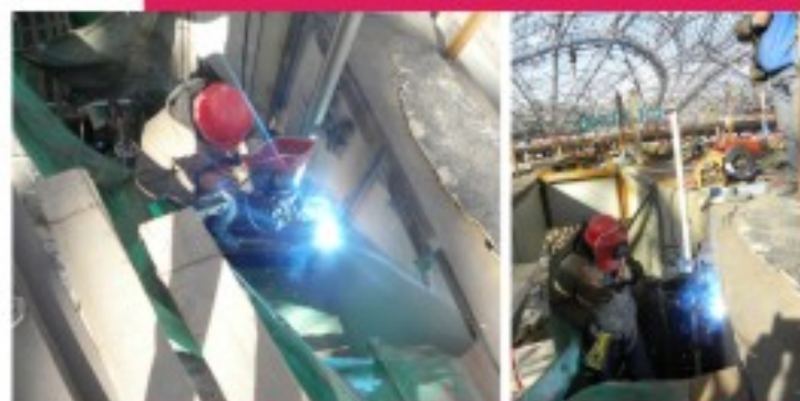
航站楼主楼与指廊连桥箱形梁现场焊接
