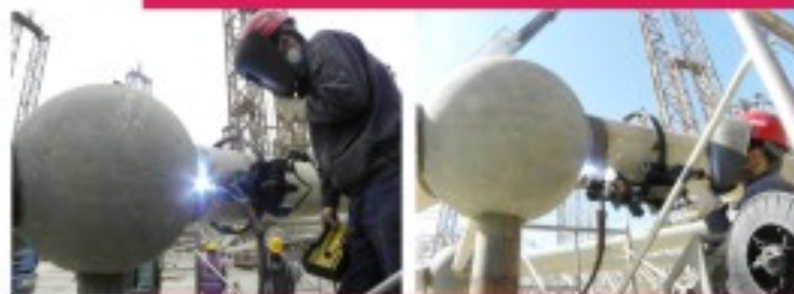
与圆管的焊接现场预制
