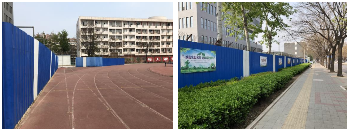
图 3-1 施工过程中采取围挡措施
