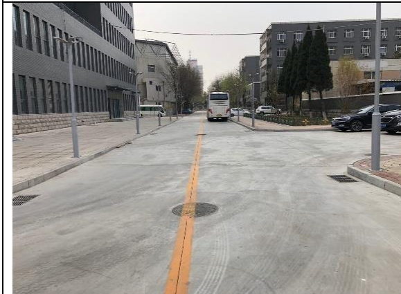
场内硬化道路
