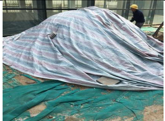
临时堆土拦挡
