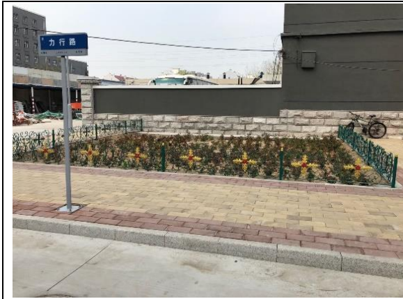
绿化措施及铺设透水砖
