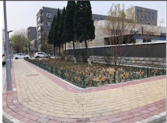
绿化措施及铺设透水砖
