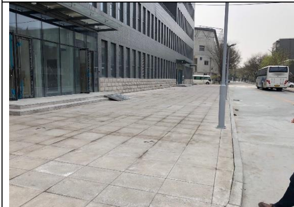
学生综合服务楼一侧硬化措施
