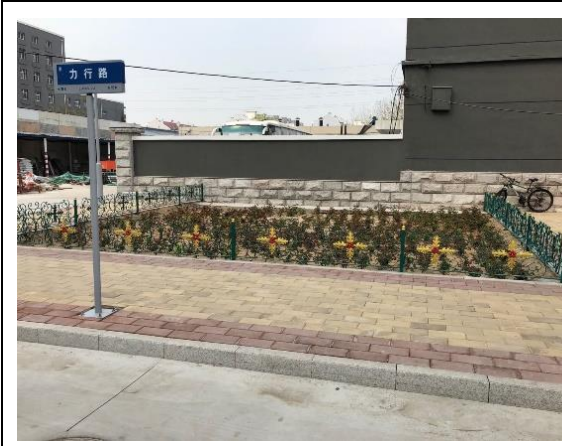
绿化措施及铺设透水砖
