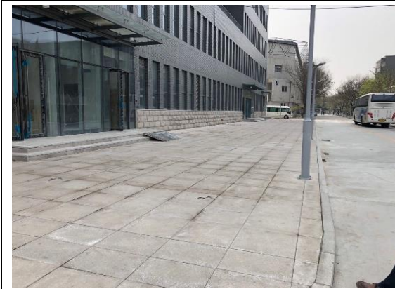
学生综合服务楼一侧硬化措施
