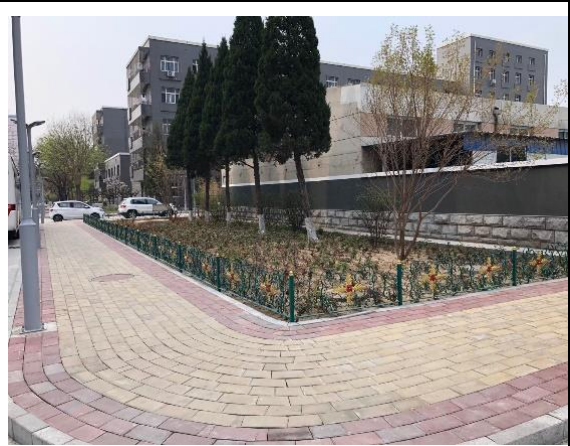
绿化措施及铺设透水砖
