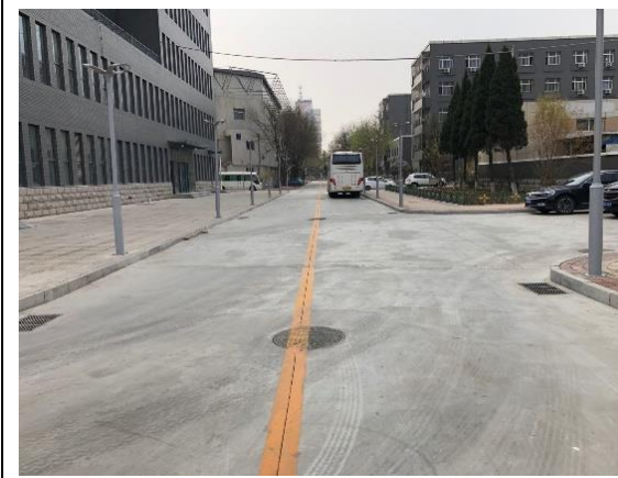
场内硬化道路
