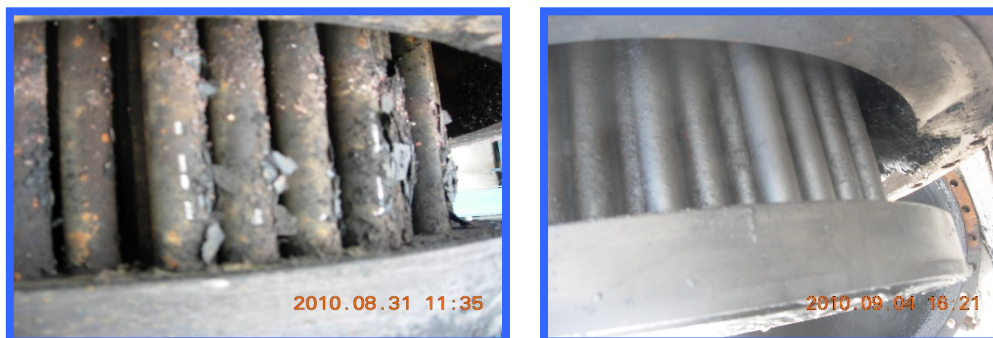
图 7 常减压装置 412/1B 清洗前后管束对比
