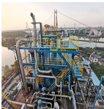
中石化巴陵石化 VOCs 回收装置
