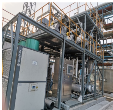
中石油锦州石化 VOCs 回收装置
