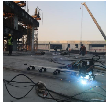
柔性轨道焊接机器人
