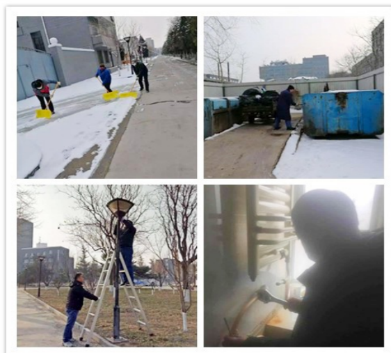
坚持24小时值班报修的制度，及时维修水电暖设施。
